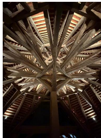
Pogled na ostrešje JZ stolpa.
